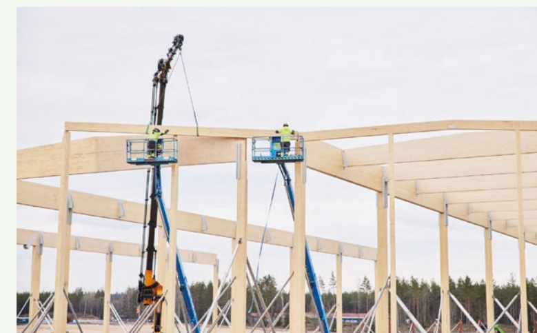
Elgigantens nye lager- og logistikkbygg i Jönköping blir et av Nordens største. Moelvns leveranse består av over 500 saltaksbjelker, og de er 24 meter lange og nesten to meter høye. Den bærende konstruksjonen i det 86 000 kvadratmeter store bygget består i sin helhet av limtre fra Moelven Töreboda AB og Moelven Limtre AS. Foto: Sören Håkanlind og Jonas Ingman
