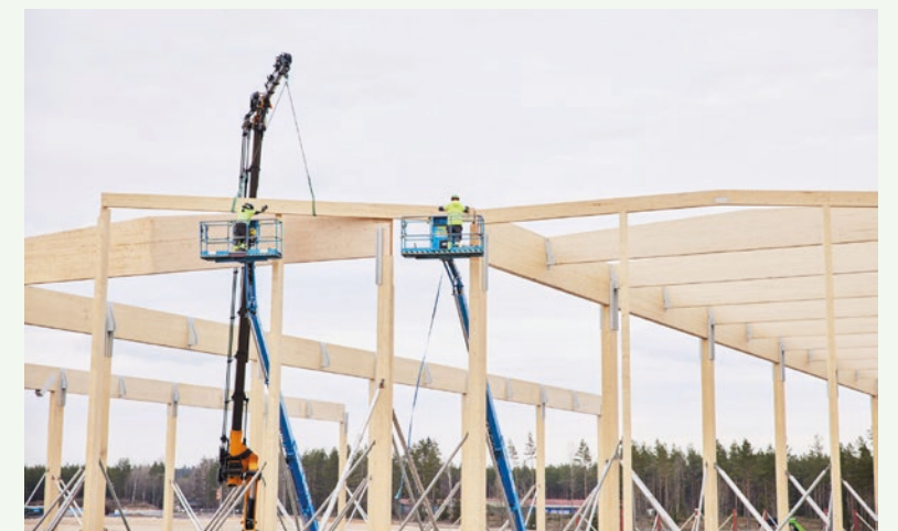
Elgigantens nya lager- och logistikanläggning i Jönköping blir en av de största i Norden. Moelven tillhandahåller över 500 sadeltaksbjälkar, vilka är 24 meter långa och nästan två meter höga. Den bärande konstruktionen i den 86 000 kvadratmeter stora byggnaden består enbart av limträ från Moelven Töreboda AB och Moelven Limtre AS. Foto: Sören Håkanlind och Jonas Ingman
