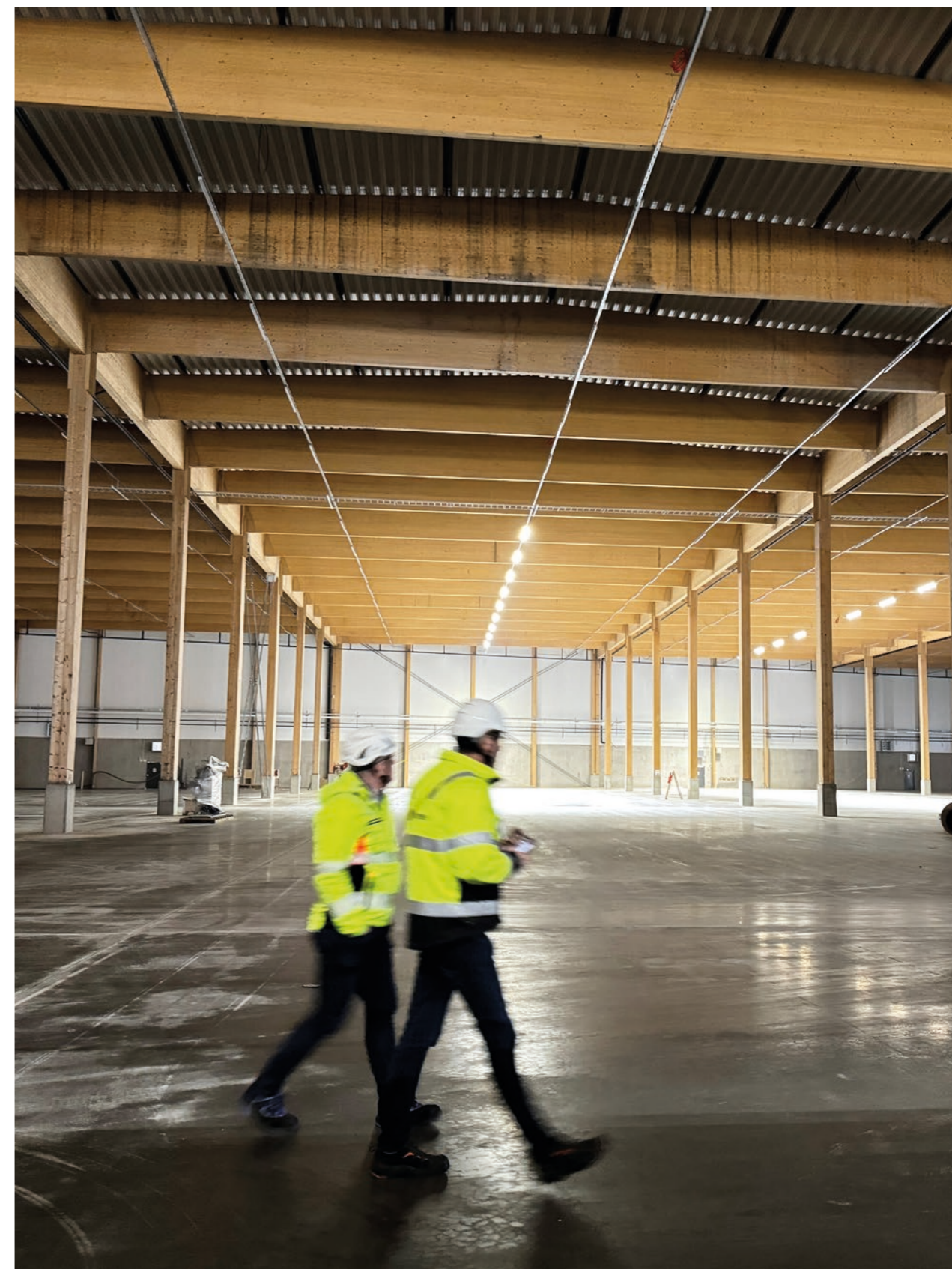
Elgigantens nya lager- och logistikaneläggning i Jönköping blir en av de största i Norden. Den bärande konstruktionen i den 86 000 kvadratmeter stora byggnaden består enbart av limträ från Moelven Töreboda AB och Moelven Limtre AS. Totalt levererades 6 300 m 3 limträ från Moelven. I limträet lagras biogent kol motsvarande ca 4 400 tCO 2 e. Som jämförelse har FN beräknat att det genomsnittliga koldioxidavtrycket per capita i Norge och Sverige 2020 var ca 6,7 tCO 2 e respektive 3,2 tCO 2 e.
